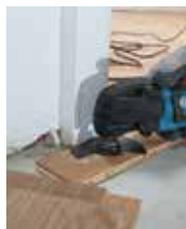
Cortes al ras de la superficie para instalación de pisos, por ejemplo.
